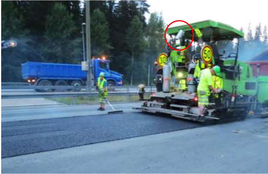
Kuva 3 Lämpökameran sijainti levittimessä on ympyröity punaisella (Kuva: Kalle Aromaa)
